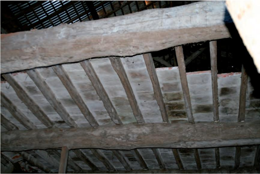
*Vue de l'isolation en brique au-dessus des foudres du vaisseau nord.*
