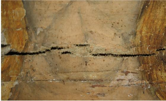
*Utilisation de morceaux de toiles servant à boucher les larges fissures des poutres.
