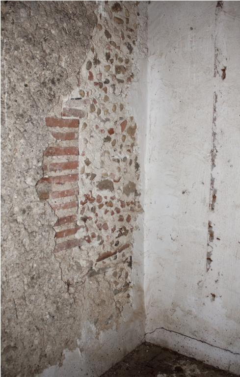
Deuxième étage. Maçonnerie rebâtie à l'emplacement supposé de la seconde échauguette.
