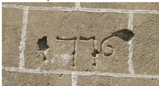
Date portée sur le mur gouttereau sud. Photographie de Daniel Pédoussat.
