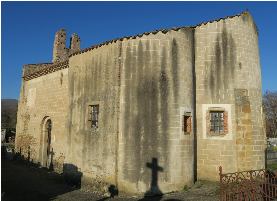
Elévation sud-est de l'église avec son portail d'entrée. Photographie de Daniel Pédoussat.
