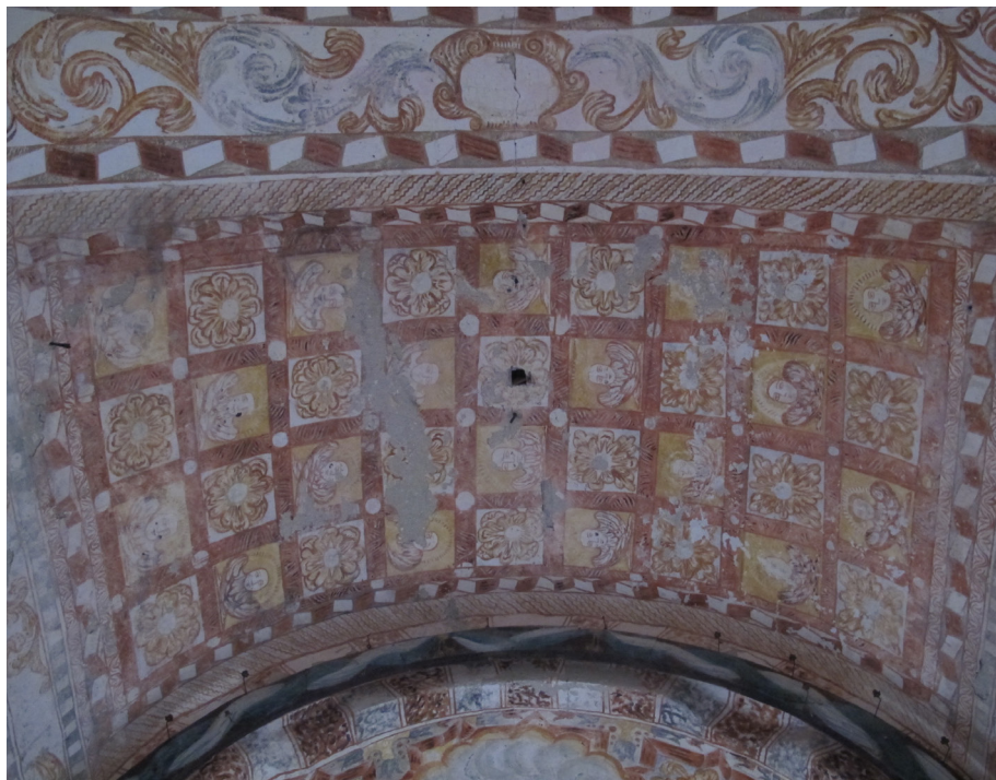
Le plafond à caissons. Photographie de Daniel Pédoussat.
