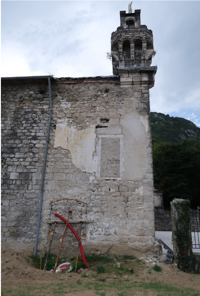
Les matériaux murant la porte qui donnait accès à la chapelle depuis la maison de Sabart sont soutenus par des étais. © Région Occitanie. Patrick Roques, 2018
